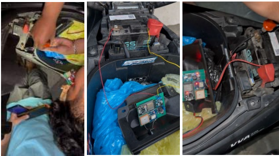
GAMBAR 5 Proses Instalasi Perangkat IoT
