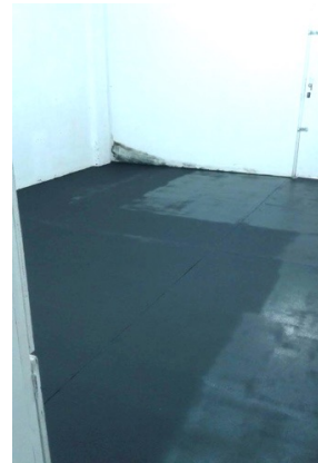
Gambar 3.15 Pengecatan Lantai Sumber: Dokumentasi Penulis (2019)
