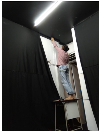
Gambar 3.19 Pemasangan tirai hitam Sumber: Dokumentasi Penulis
