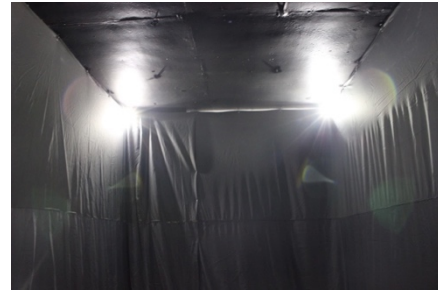
Gambar 3.21 Sisi kiri ruang instalasi Sumber: Dokumentasi Penulis
