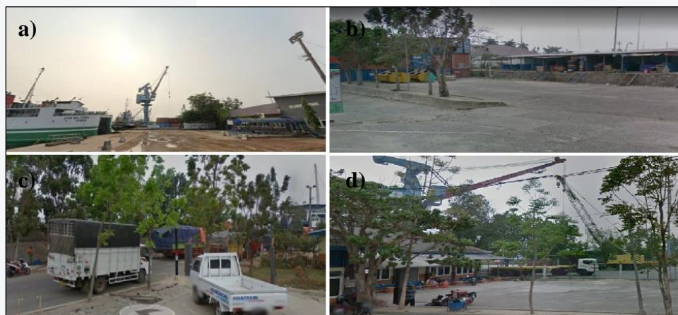
Gambar 1. Batas bangunan sekitar terminal pelabuhan, a) Utara, b) Selatan, c) Barat, d) Timur Sumber : Data Pribadi
