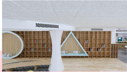
Gambar 7 DC Ducting Sumber: Dokumen Penulis
