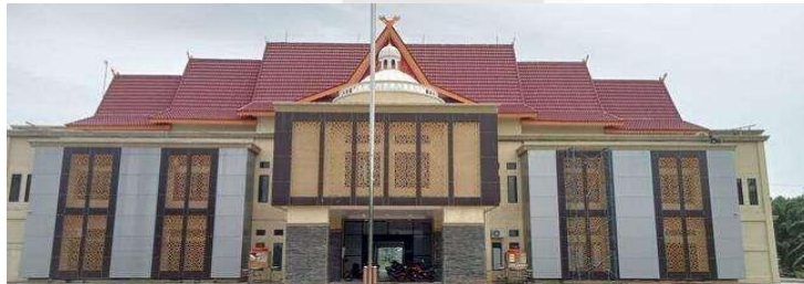
Gambar 1 Bangunan Kantor Kecamatan Bandar Laksamana
