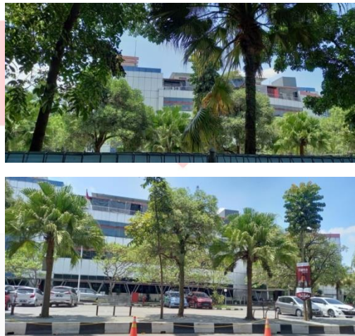
Gambar 3.1 Observasi Gedung Bangunan Fakultas Ilmu Terapan Sumber: Data Pribadi 2022
