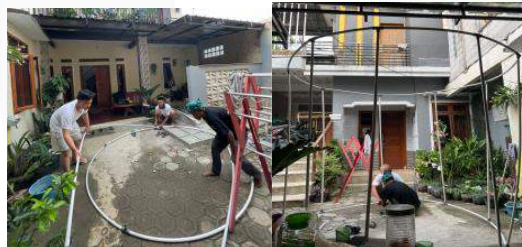
(Gambar 17 Proses Pembuatan Kerangka Tiang Ruang) Sumber Gambar : Dokumen Pribadi Penulis, 2023
