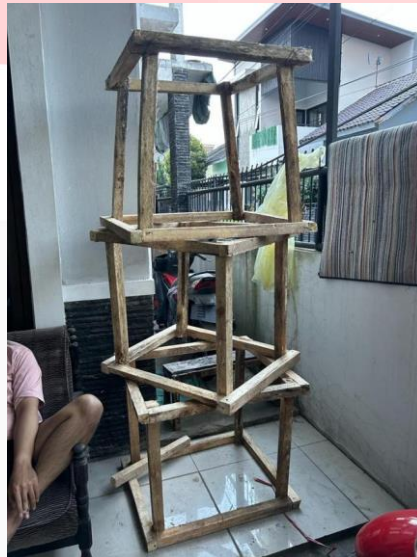
Gambar 2 Pembuatan pondasi Sumber: Pribadi (2023)
