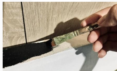
Gambar 15. Proses finalisasi Sumber: dokumentasi pribadi
