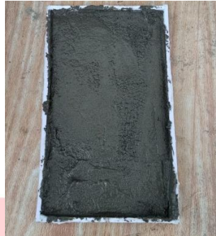
Gambar 15. Pemasangan fiber glass tape Sumber: Penulis, 2024
