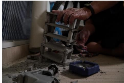
Gambar 16 Proses Penghancuran gedung Sumber: Penulis, 2024
