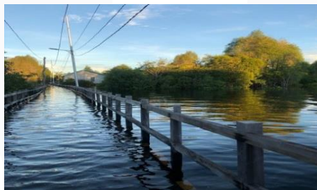
Gambar 3 Kondisi Sungai Sebelum Adanya PETI Sumber: Dokumentasi Pribadi
