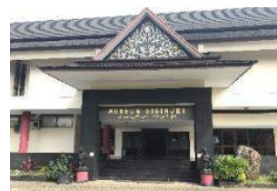
Gambar 2 Gedung Museum Siginjei Sumber: Dokumentasi Pribadi (2018)
