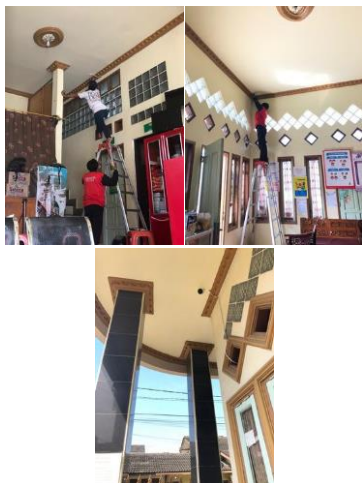
Gambar 4. Titik Pemasangan CCTV
