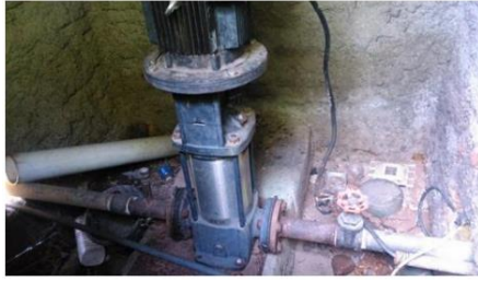
Gambar 3. Pompa Eksisting yang diperbaiki
