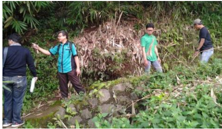
Gambar 5. Perbaikan saluran ke bak penampungan
