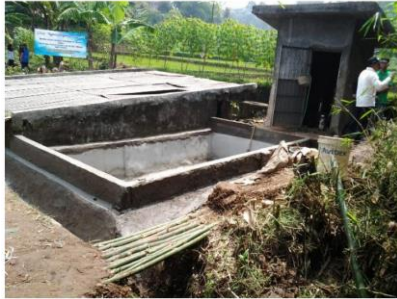
Gambar 4. Bak penampungan dan pompa yang diperbaiki
