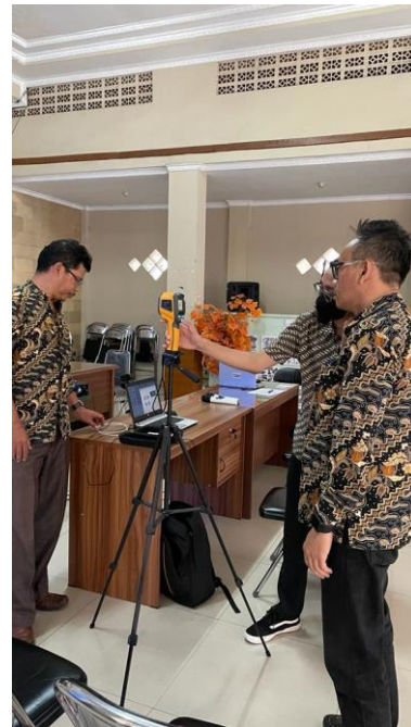
Gambar 2. Dokumentasi pemasangan perangkat
