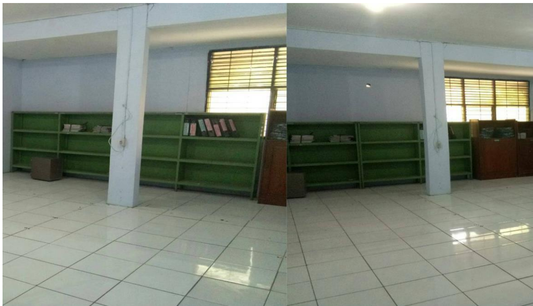
Gambar 4. 1 Kondisi Ruang Data Center Saat Ini (CV Media Smart)
