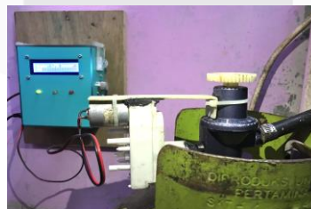
Gambar 4.1 Pemasangan Sistem pengendali kebocoran LPG di dapur.
