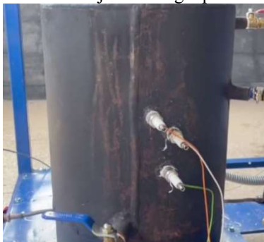
Gambar 4. 16 Letak water level
