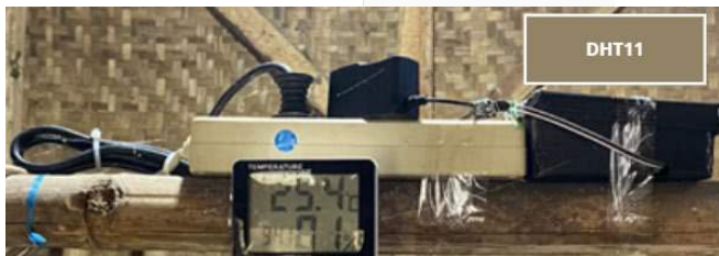
GAMBAR 2 Instalasi Modul Suhu Kelembapan
