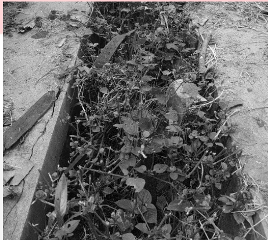
Gambar 10 Sistem drainase di lingkungan data center
