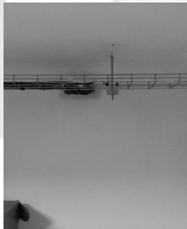
Gambar 8 Dinding di dalam data center
