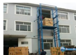
GAMBAR 2 - 1. Contoh lift barang pada bangunan pabrik
